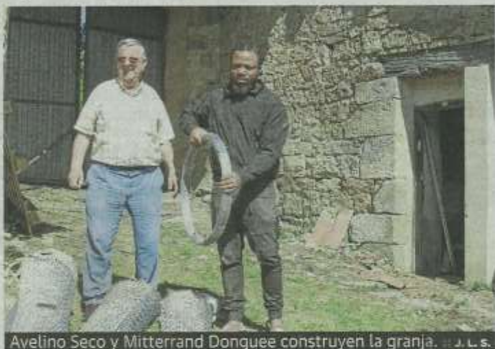
Avelino Seco y Mitterrand Donquee construyen la granja. :: J. L. S.
